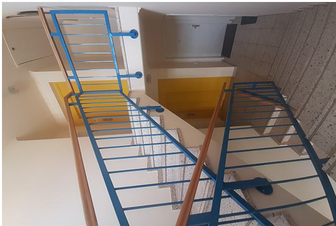
Treppenhaus mit Aufzug
