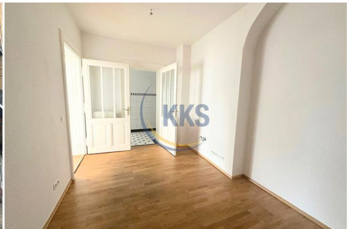
Flur mit Wasseranschlüssen
